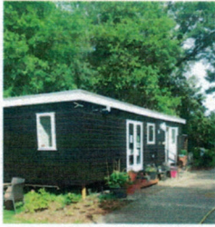
Er is een nieuwe beheerderswoning geplaatst bij de Paradijsvogelwoningen.
