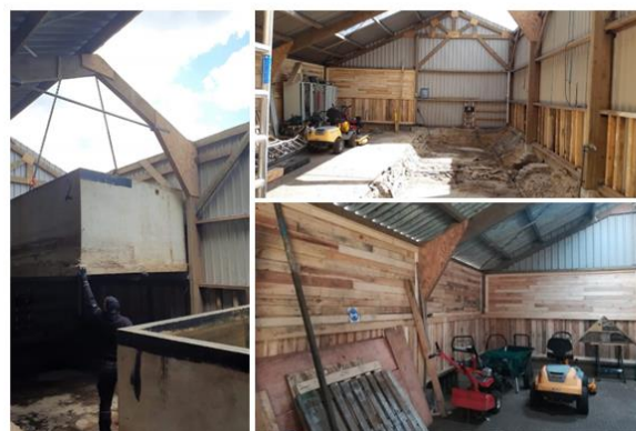
Verbouwing kapschuur Forelderij
